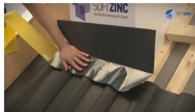
Klebefolie entfernen
