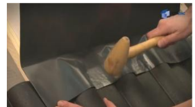
SOFTZINC mit geeignetem Werkzeug exakt nachformen
