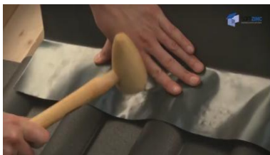
SOFTZINC-Anschluss an Deckung oberflächlich anpassen
